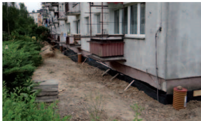
Blok przy ul. Toporowskiego 81, prace przy izolacji ścian fundamentowych
