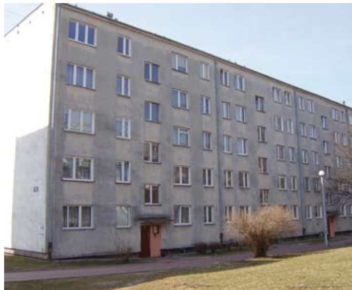
Klonowa 46 - elewacja przed remontem
