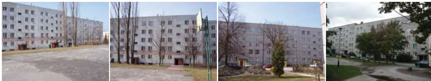
Orkana 40 - elewacja przed remontem
