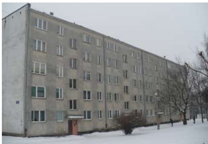
Klonowa 46 - elewacja przed remontem
