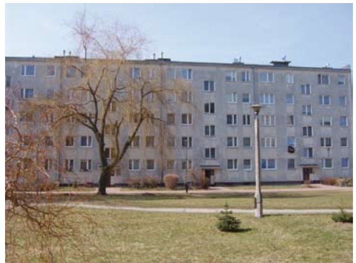
Klonowa 52 - elewacja przed remontem
