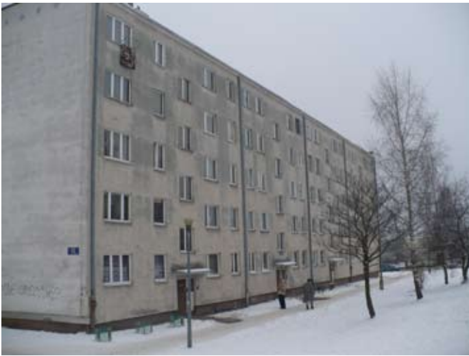
Klonowa 52 - elewacja przed remontem
