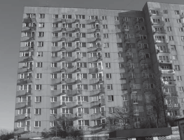
Wieżowiec przy ul. Orkana 3 pokryty jest płytami azbestowo-cementowymi od góry do dołu. Stan płyt Spółdzielnia sprawdza każdego roku
