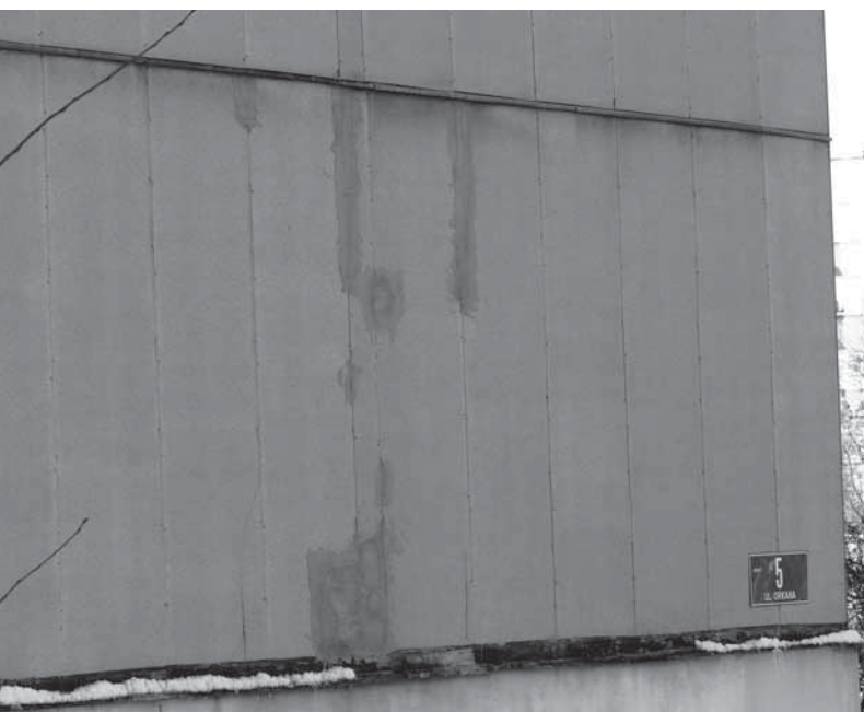
Uszkodzenia płyt azbestowo-cementowych są naprawiane na bieżąco. Na zdjęciu ściana szczytowa bloku przy ul. Orkana 5
